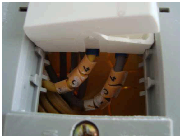
Identificação de condutores com anilhas
