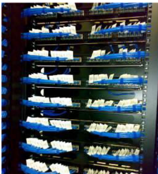
Ex.Raios de curvatura, amarras e identificação para cabos UTP
