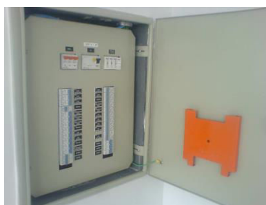
Quadro (Porta-projetos, aterramento, identificação de circuitos)
